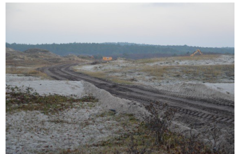
Afgraven ten zuiden van de Mariaweg
